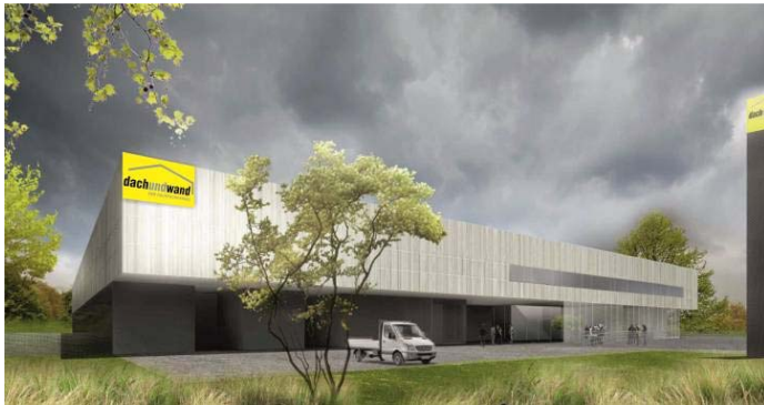
Die Firmenzentrale "Dach und Wand" wird 2017 nach Eberstalzell (OÖ) verlegt. Der Standort von "Dach und Wand" unter der Marke „Carl Steiner Dachfachhandel“ bleibt in Salzburg.
